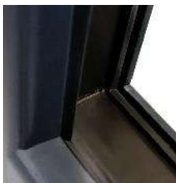
Existen varias configuraciones de unión de los travesaños, unión mecánica o unión soldada, esta última ofrece mayor aislamiento y estanqueidad, pero, sin embargo, no todas las series admiten la posibilidad de una unión soldada del travesaño.
